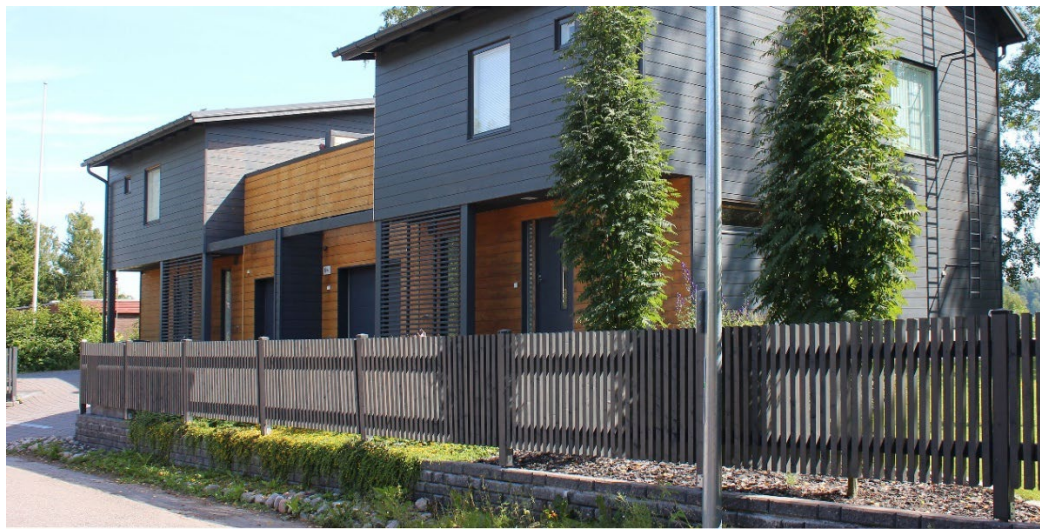
Kuva 3. Kuvan aita on sovitettu yhteen rakennuksen arkkitehtuurin kanssa.
