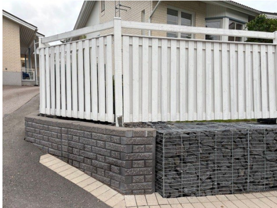
Kuvat 10–11. Kohteessa on valittu väärä tapa toteuttaa tukimuurin kadunvastaiselle rajalle. Kivimuurin ei sovi pienipiirteisiin muotoihin. Ongelmakohta on jouduttu ratkaisemaan muurityyppiä vaihtamalla, mikä ei ole johtanut hyvään lopputulokseen. Kivimuurin ei myöskään sovi aidan perustaksi. Tässä kohteessa aita kallistui jo vuoden päästä rakentamisesta.
